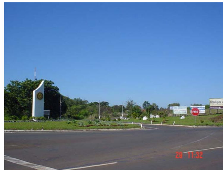
Fig. 3.5.24 – Trevo PR 090 x prolongamento da Av. Rio de Janeiro
